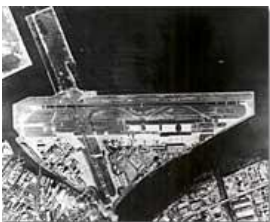
1970年B滑走路延長工事（国土交通省ホームページより）
