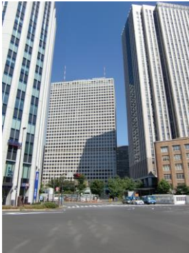
超高層ビルに囲まれた「霞が関ビル(高さ147m、36階建て)」。右手の低層部は歴史的建造物を活用した文部科学省 撮影：2011年7月10日
