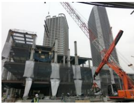
現在工事中の大規模商業施設 撮影：2013年11月25日
