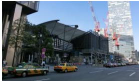
多くのタクシーや高速バス等が発着する八重洲口広場。4階建てのペデストリアンデッキ「グランルーフ」の工事が行われている 撮影：2012年9月11日
