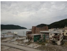
女川市の鉄筋コンクリート造りの倒れた建物 まだまだ街の復興までの道は険しいといわざるを得ない 撮影：2011年7月4日
