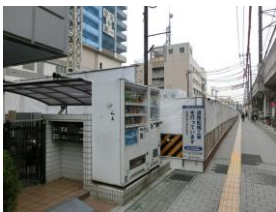
ブラウドタワーの前面道路 の拡幅工事。手前の建物も撤 去される予定だ。 撮影：2013 年 11 月 25 日
