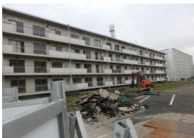
再開発のために取り壊し中の新日本石油の小杉アパート 撮影：2013年11月25日
