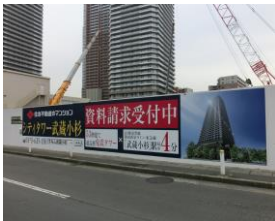
現在工事中のシティタワー 武蔵小杉(53階建て、約185m) は販売価格を抑えるため、 55.23㎡～72.35㎡とコンパクトになっている。 撮影：2013年11月25日
