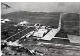
1931年東京飛行場開港の時代（国土交通省ホームページより）
