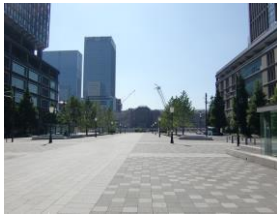
景観に配慮して建物低層部の壁面の高さを31mで合わせている丸ビル(右)と新丸ビル。正面は工事中的の東京駅 撮影：2011年7月
