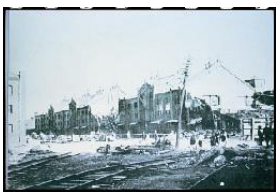
震災後の横浜の赤煉瓦倉庫。1号館の中央が崩壊。その後、海側部分だけ残して再生し現在に至る(横浜市提供)
