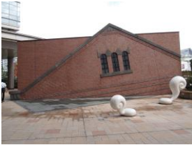
残す意義が感じられないミ ューザ川崎前広場の JR 変電 所の壁 撮影：2011 年 10 月 16 日
