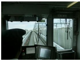
ニューシャトルは新幹線と一体となった構造となっている 撮影：2015年1月27日
