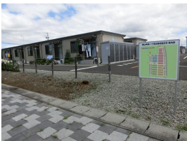
「ビッグパレットふくしま」の隣接地にある「郡山南1丁目応急仮設住宅」には、今も原発被害の大きい富岡町などの住民が入居している。 撮影：2015年6月29日
