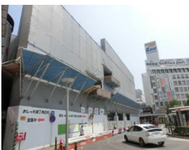
駅前の「箱根登山ベルジュ」 の跡地では新規施設の工事 が進んでいる。 撮影：2015 年 8 月 3 日
