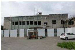
解体工事が決まり仮囲いがある旧大槌町役場。 撮影：2014 年 6 月 22 日
