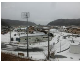
岩泉小本駅周辺は、新築ばかりなので、津波被害が大きかったようだ。 撮影：2016年1月24日
