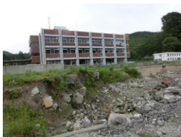
3 階だけを利用している大気海洋研究所国際沿岸海洋研究センター。 撮影：2014 年 6 月 22 日
