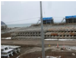
海岸部は防潮堤の工事が盛んだ。 撮影：2016年1月24日
