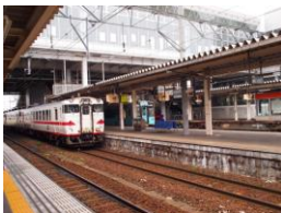
三陸縦貫鉄道の起点駅「八戸駅」 撮影：2011 年 7 月 11 日
