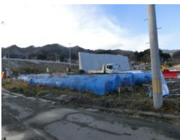
吉里吉里海岸の山側は道路の付け替え工事が行われている。 撮影：2016年1月24日
