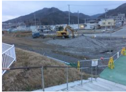
J R 大船渡駅のあった場所は、現在、造成工事中だ。 撮影：2015 年 1 月 25 日
