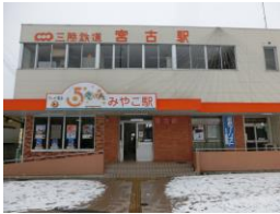
三陸鉄道北リアス線の宮古駅。この先、釜石までの山田線は将来、三陸鉄道に移管される。
