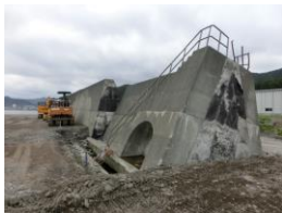
津波で壊された赤浜地区の防潮堤。 撮影：2014 年 6 月 22 日
