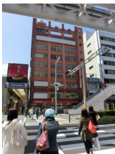
小倉駅前コレットの向かいの小倉中央商店街の入り口にあるビルは1階部分以外が使われている気配がない
