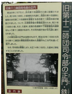
小倉城址に揭示されている旧第 12 師団司令部の概要と当時の写真 撮影：2013 年 4 月 21 日
