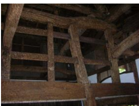
柱という柱が彫刻刀で刻まれている「脱皮する家」 撮影：2006年8月25日
