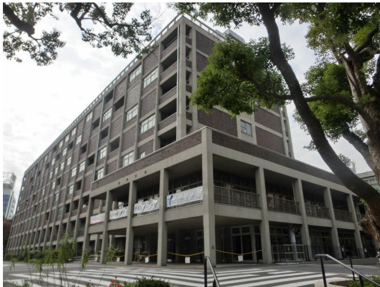
現在の横浜市役所は免震構造になっている。設計は村野藤吾 撮影：2015 年 11 月 7 日
