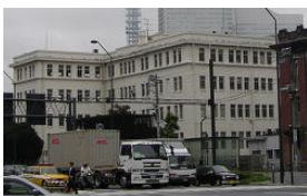
NDCグラフィックスの入居していた帝産倉庫事務所棟
